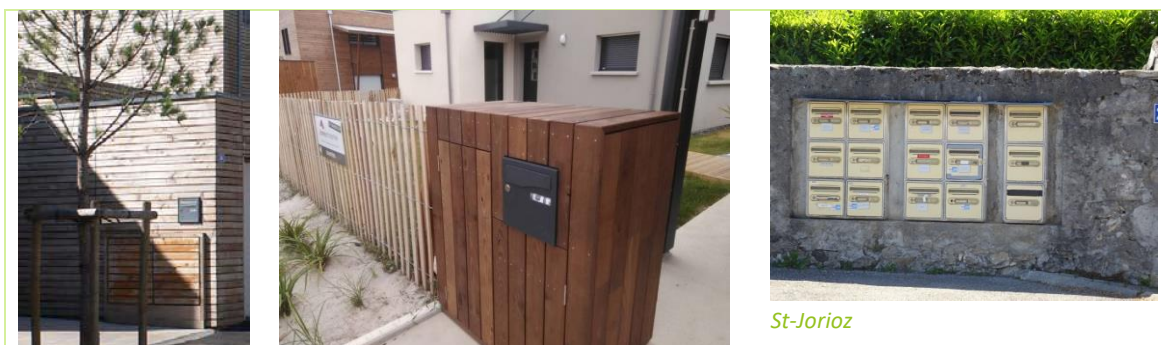
Image 64 - Intégration des éléments techniques dans la clôture
